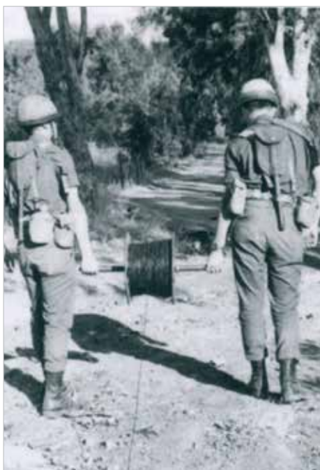
סלילת כבל שדה ח-10, בעזרת שני קוונים (מקור: אוסף העמותה להנצחת חללי חיל הקשר והתקשוב)
