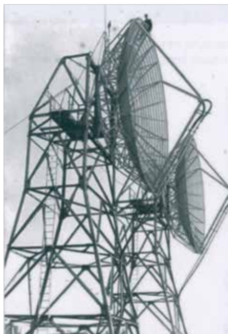
אנטנת עורק זירוי טרופוספרי, שהוקמה במהלך מלחמת ההתשה ונועדה לאפשר קשר טוב יותר עם הבסיסים בסיני (מקור: אוסף העמותה להנצחת חללי חיל הקשר והתקשוב)
