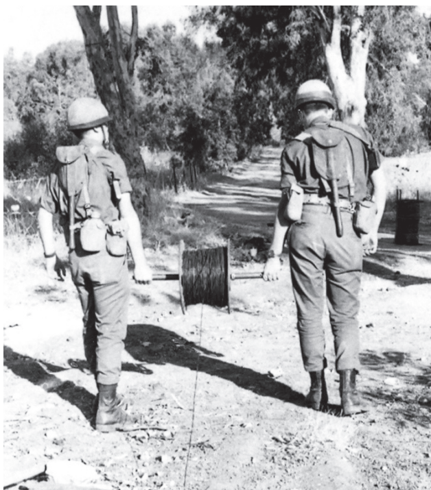
סלילת כבל שדה ח-10 עם תפ-5 הנישא בידי שני קוונים בעזרת גל-27 מקור: אוסף העמותה להנצחת חילי הקשר והתקשוב
