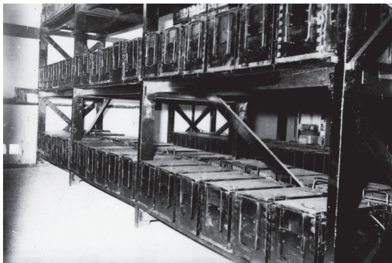
מצברים באחסנה יבשה מקור: אוסף העמותה להנצחת חיל הקשר והתקשוב
