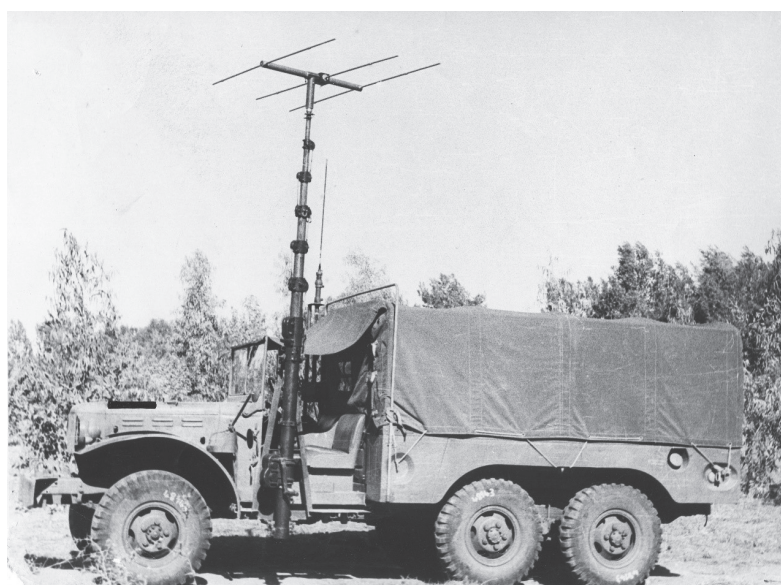
רקש-312 עם אנ-200 תורן האנטנה הטלסקופי אנ-910 נושא אנטנת אנ-200. באדיבות ארכיון צה"ל ומערכת הביטחון, 77920/0
