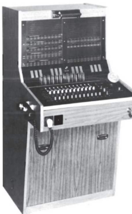
מרכזיה ידנית דגם 93, בתחזוקת משרד התקשורת מקור: אוסף העמותה להנצחת חילי חיל הקשר והתקשוב
