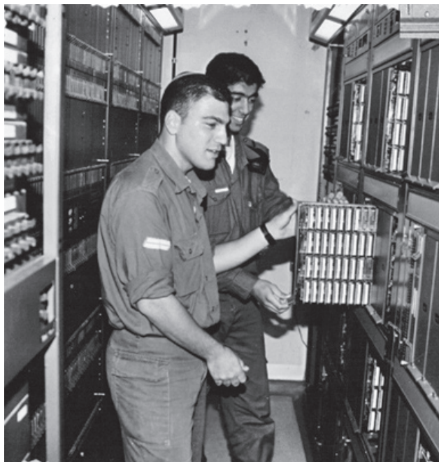
תחזוקת מתג טלפוניה ב"אבן יקרה" מקור: אוסף העמותה להנצחת חללי חיל הקשר והתקשוב
