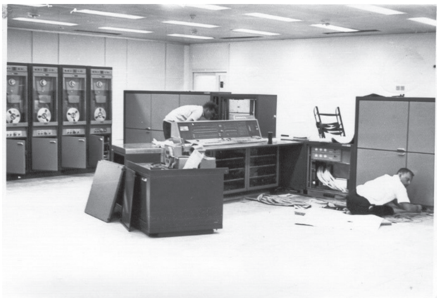
אולם המחשב המרכזי בממ"ם בשנות השישים עמדת הפעלה במרכז, כונני סרטים מגנטיים משמאל באדיבות ארכיון ממ"ם
