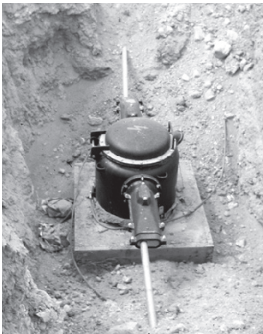
מיכל מגברים בכבל קואקסיאלי מגברים הותקנו כל כ־70 ק"מ מקור: אוסף העמותה להנצחת חללי חיל הקשר והתקשוב
