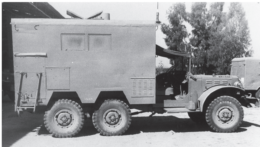
רקש-120, רק"ש רדיו ת"ג ותג"ס, מרכב פח על רכב 6x6 מקור: אוסף העמותה להנצחת חילי חיל הקשר והתקשוב
