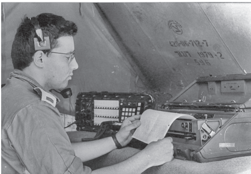
פקסימיליה פקס-7 ומרכזיית שדה מרכז-3614 מקור: אוסף העמותה להנצחת חילי חיל הקשר והתקשוב
