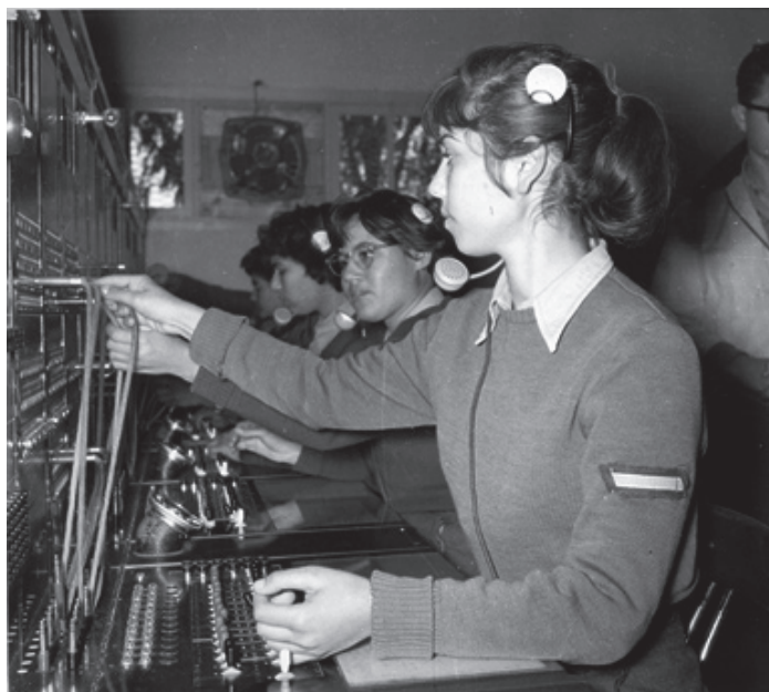
מרכזיה ידנית דגם 96, בתחזוקת משרד התקשורת מקור: אוסף העמותה להנצחת חילי חיל הקשר והתקשוב
