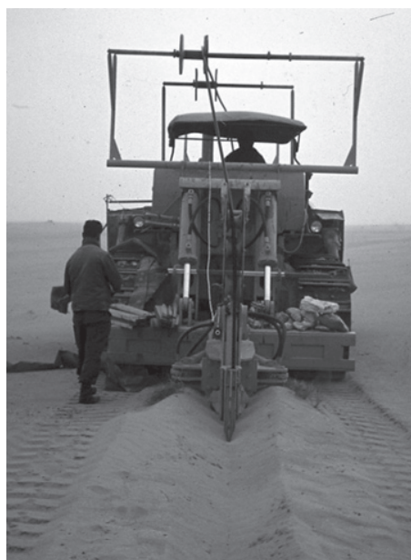
מחרשת כבלים, ששימשה את משרד הדואר במרחבי סיני מקור: אוסף העמותה להנצחת חילי חיל הקשר והתקשוב
